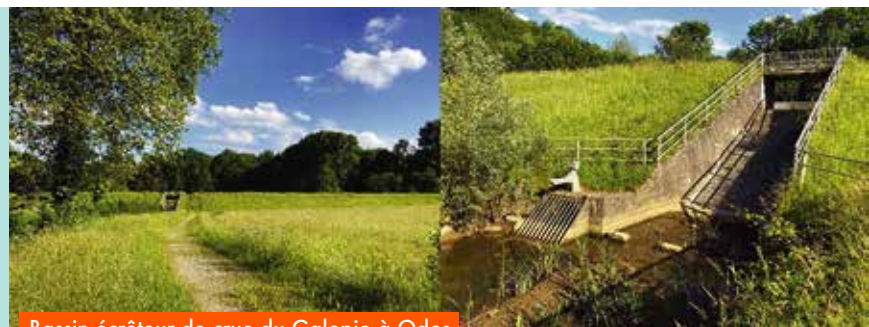
Bassin écrêteur de crue du Galopio à Odos
